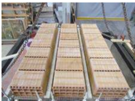
REALIZZAZIONE DEL SOLAIO
