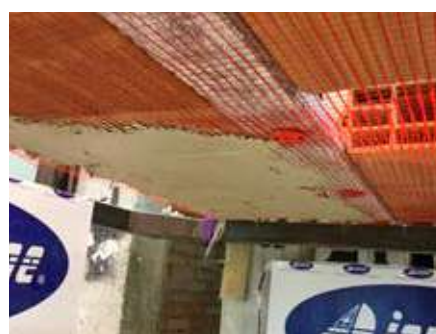
APPLICAZIONE INTONACO
