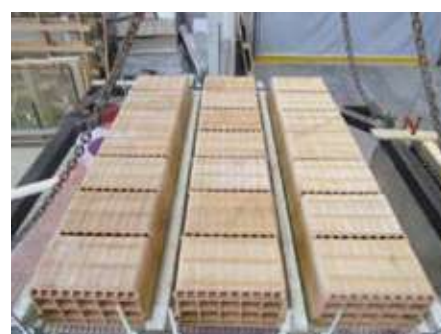
REALIZZAZIONE DEL SOLAIO
