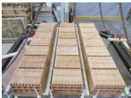
REALIZZAZIONE DEL SOLAIO
