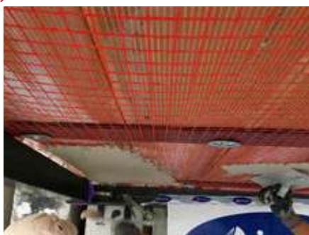
APPLICAZIONE INTONACO
