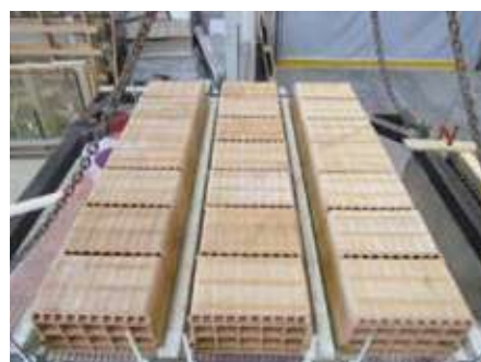
REALIZZAZIONE DEL SOLAIO
