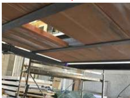
REALIZZAZIONE DEL SOLAIO
