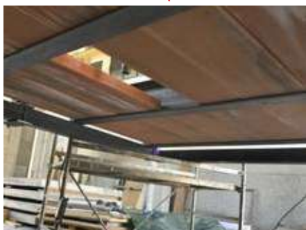
REALIZZAZIONE DEL SOLAIO
