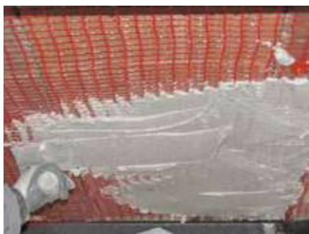
APPLICAZIONE INTONACO
